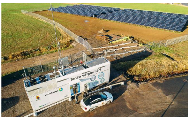
Figur 5.2. Tankstation för vätgas tillverkade med solceller i Mariestad (foto André Nordblom, 2019).
