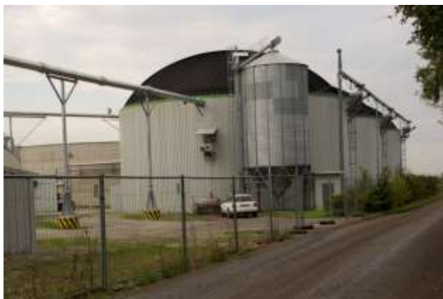
Figur 1.13. Biogasanläggning i Pliening (Foto: David Ljungberg).
