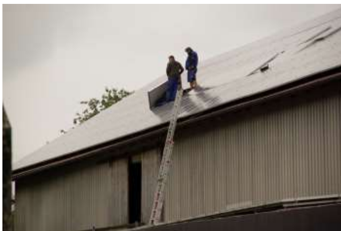
Figur 1.20. Installation av solceller på lantbruksbyggnad (Foto: Carina Gunnarsson).
